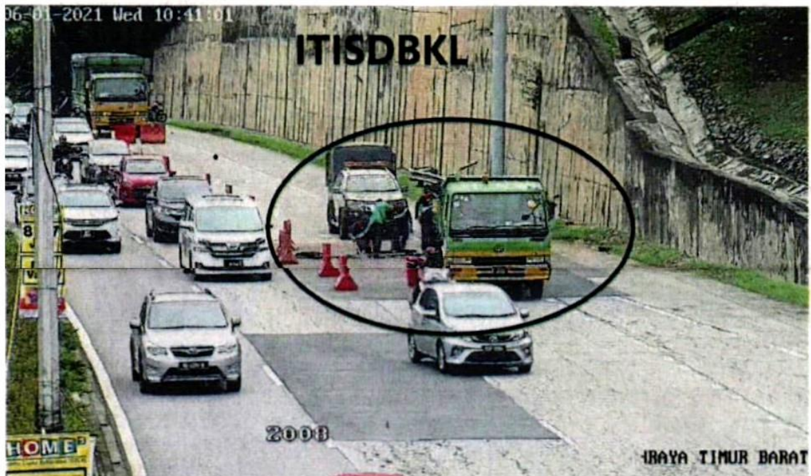
■隆市政局公共工程与排水局,封锁东西连贯大道两条车道,以便展开铺路工程。
